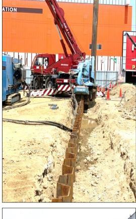
クレアホームズ糸島 ザ・レジデンス新築工事 福岡県糸島市浦志地内 施工場所 民間 注 者 発 株式会社森本組 元請業者 下請業者 株式会社橋本組 有限会社池上クレーン 施工業者 2019年5月~2019年6月 施工期間 ECO-100 SR-250R 施工機械 SP3型 L=7.0m n=364枚 型式・寸法 特徵·効果
